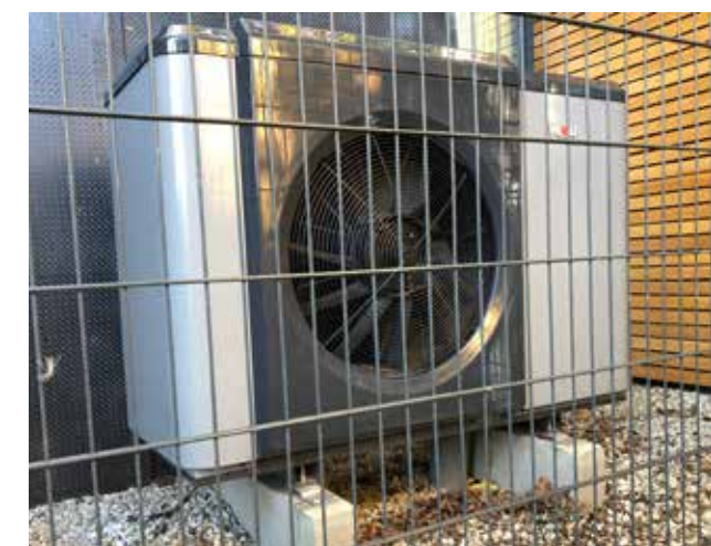
Gekozen is voor een WOLF CHA-monoblock warmtepomp met een capaciteit van 10 kW.
