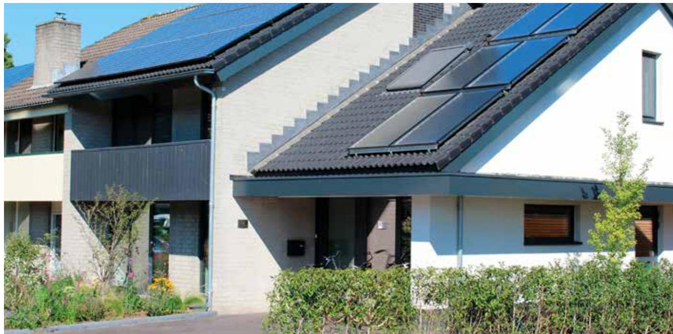
Begin dit jaar was de WOLF Energiesystemen betrokken bij de verduurzaming van een twee-onder-een-kapwoning uit 1975, waar dankzij een WOLF warmtepomp, meerlagenbuffervat, verswaterstation, WTW-woonhuisventilatiesysteem én zonnecollectoren een flinke energetische en comfortslag gemaakt kon worden.
